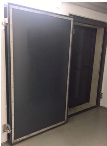
**Zone 1** wird durch eine Hochwasserschutztür sowie eine zusätzliche Tür mit Zutrittskontrolle geschützt. Die Hochwasserschutztür ist grundsätzlich geöffnet und wird im Bedarfsfall (drohendes Hochwasser, Starkregen etc.) durch das Personal der IT geschlossen.
