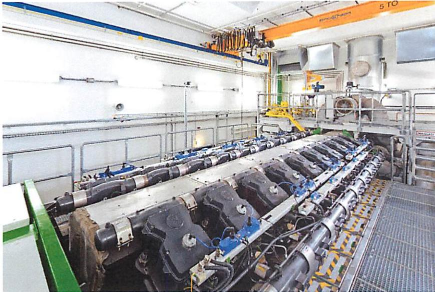
*Bild: Blick auf den stärksten Gasmotor der Stadtwerke, den J920 von GE*
