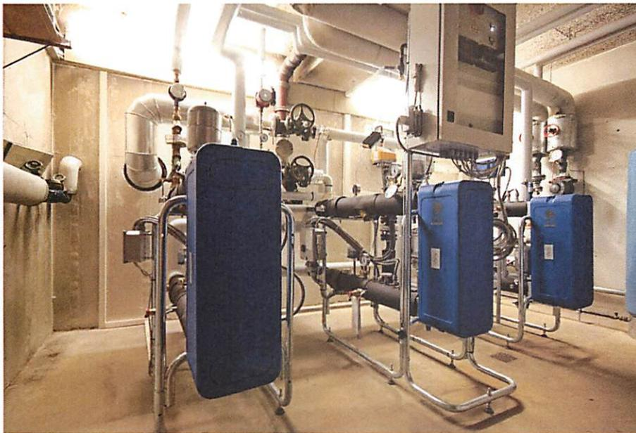
*Bild: Fernwärmekaskade der Stadtwerke Rosenheim*
