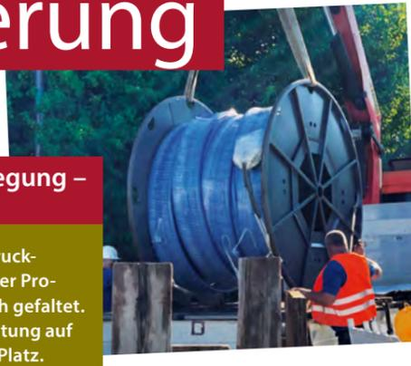
**2** Eine Seilwinde zieht das gefaltete Rohr in die vorbereitete und außer Betrieb genommene Trinkwasser-Zuleitung ein.
