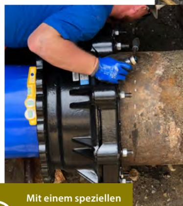
**5** Sicher mit einem geflanschten Formstück verbunden, wird der erneuerte Zuleitungsabschnitt wieder ins Trinkwassernetz eingebunden.
