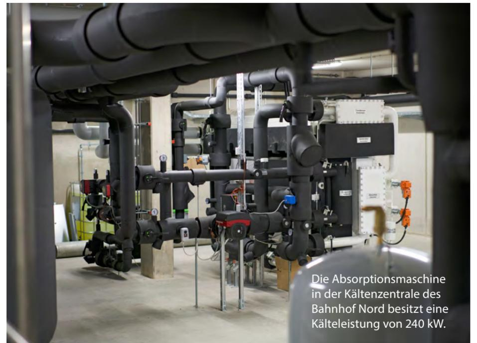
Die Absorptionsmaschine in der Kältezentrale des Bahnhof Nord besitzt eine Kälteleistung von 240 kW.
