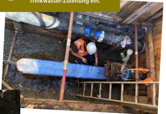
**3** Das gefaltete Rohr wird mit Luft aufgepumpt, bis das Rohr seine ursprüngliche runde Form wieder einnimmt.
