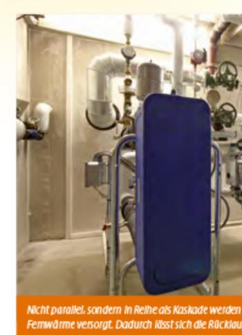
Nicht parallel, sondern in Reihe als Kaskade werden diese kompakten Plattenwärmeübertrager mit Fernwärme versorgt. Dadurch lässt sich die Rücklauftemperatur auf bis zu 30° C absenken.
