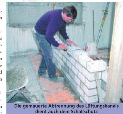
Die gemauerte Abtrennung des Lüftungskanals dient auch dem Schallschutz
