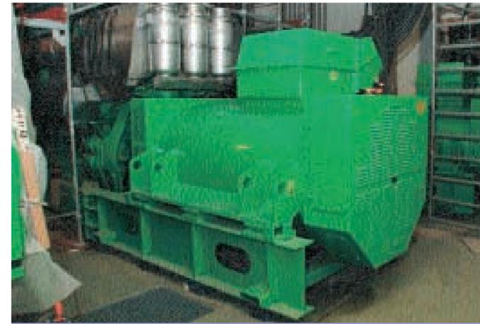
Der an den Motor angeflanschte Generator sorgt für Strom
