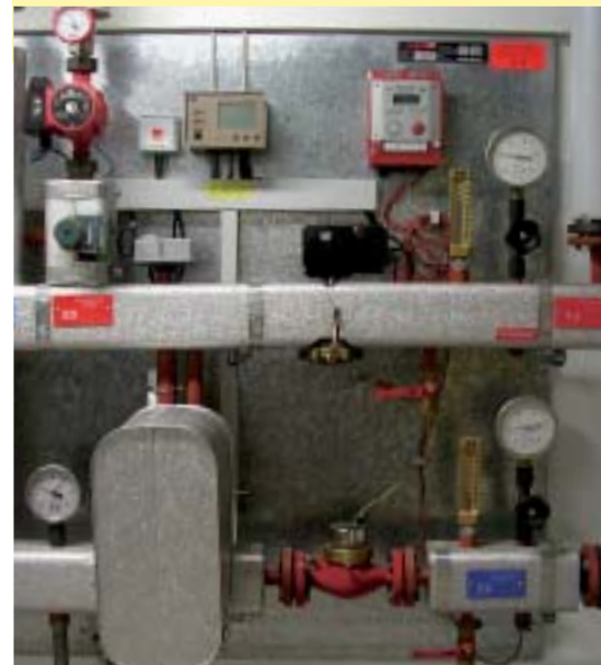
Die Fernwärme-Hausstation
