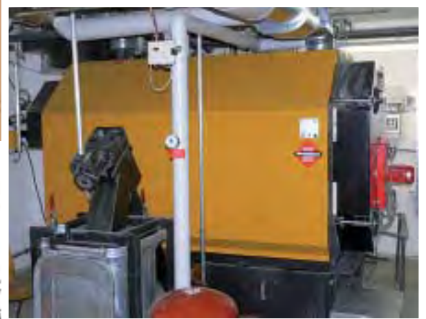
Dezentrale Wärme-Insel: Hackschnitzelheizung in der Möslstraße
